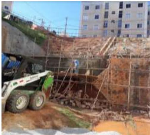
Figura 02: Remoção do muro em aterro e início do solo grampeado.
