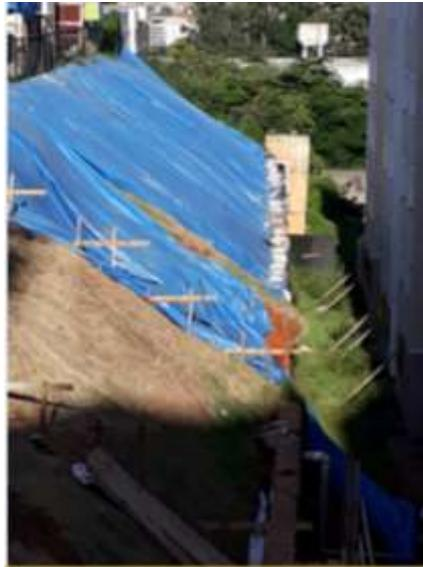
Figura 01: contensão em terra e rompida.
