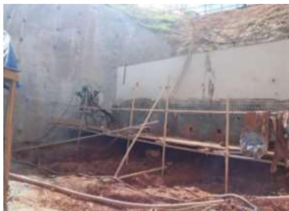
Figura 11 – Cavalete de perfuração utilizando martelo de fundo.
